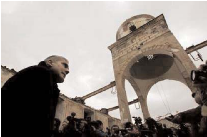
Пред разрушеном црквом Св. Николе у Пристини In front of destroyed St. Nikolas church in Pristina
